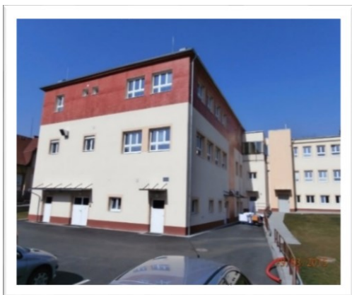
Pohled na přístavbu z jižní strany
