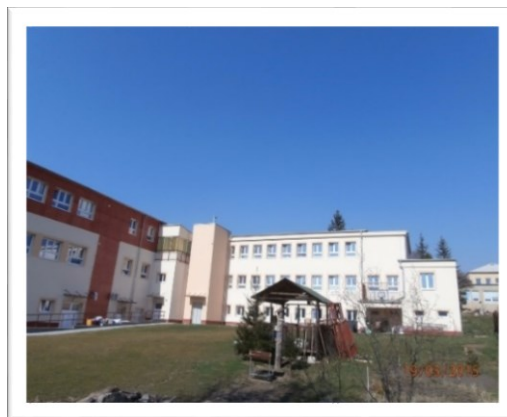
Původní budova po rekonstrukci
