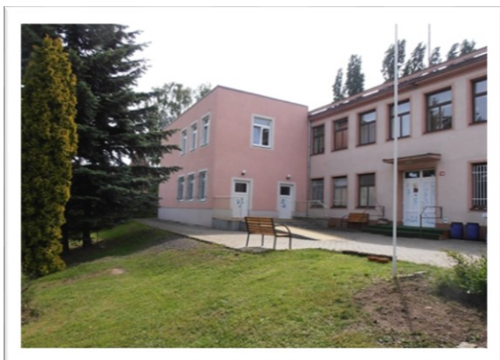
Pohled na budovu před rekonstrukcí
