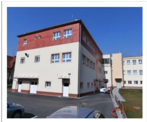
Pohled na přístavbu z jižní strany
