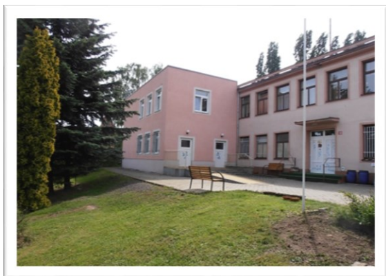
Pohled na budovu před rekonstrukcí
